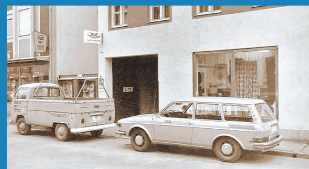
Ein Blick ins Fotoalbum: Die Firma Bad & Heizung Ruf in der Hechtenstraße.
